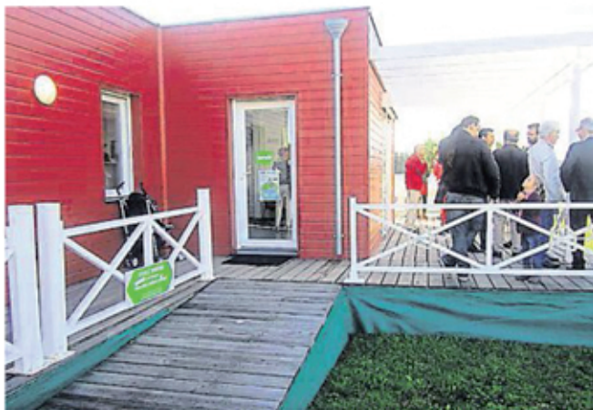
Une vue extérieure de la Maison pour agir.
